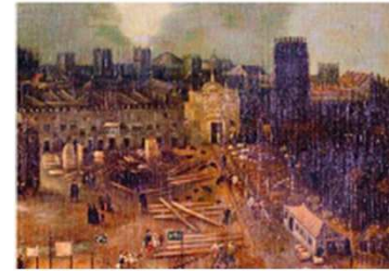
La Casa de Contratacion
