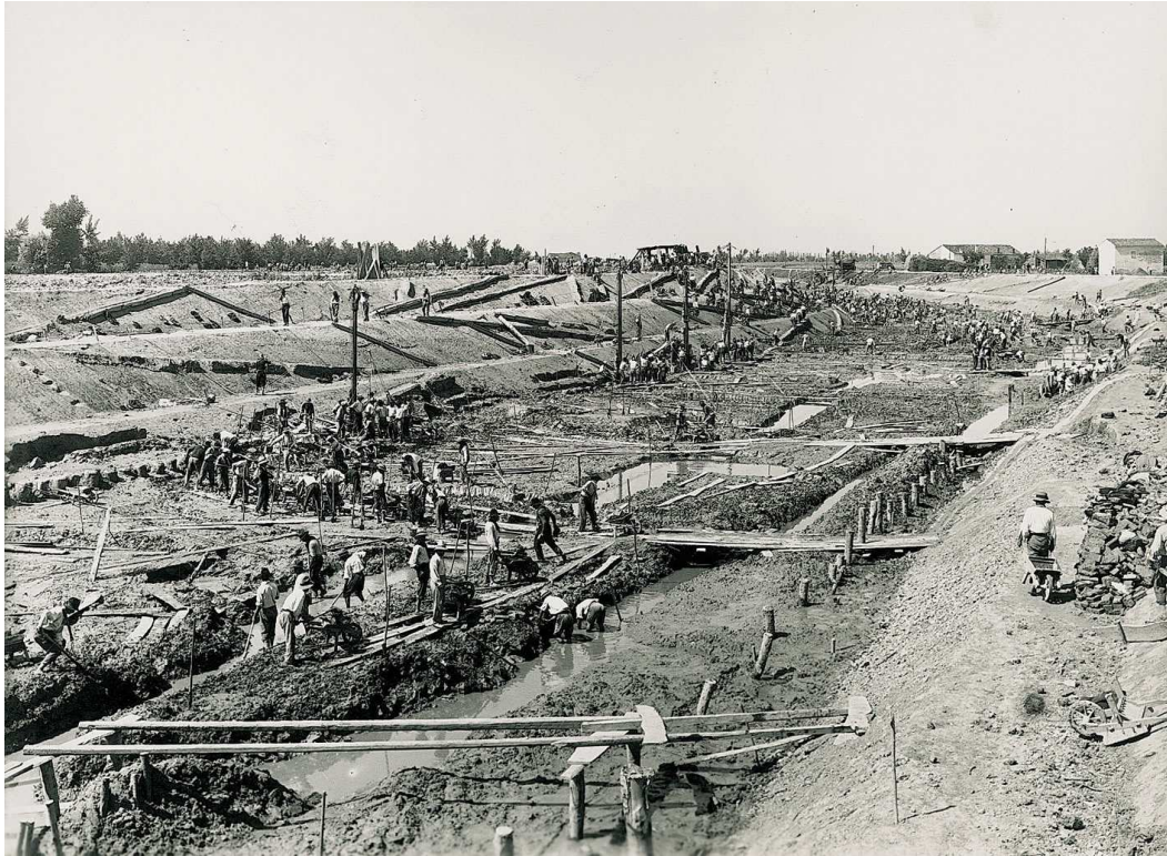
Travaux d'assainissement du Marais Pontin
