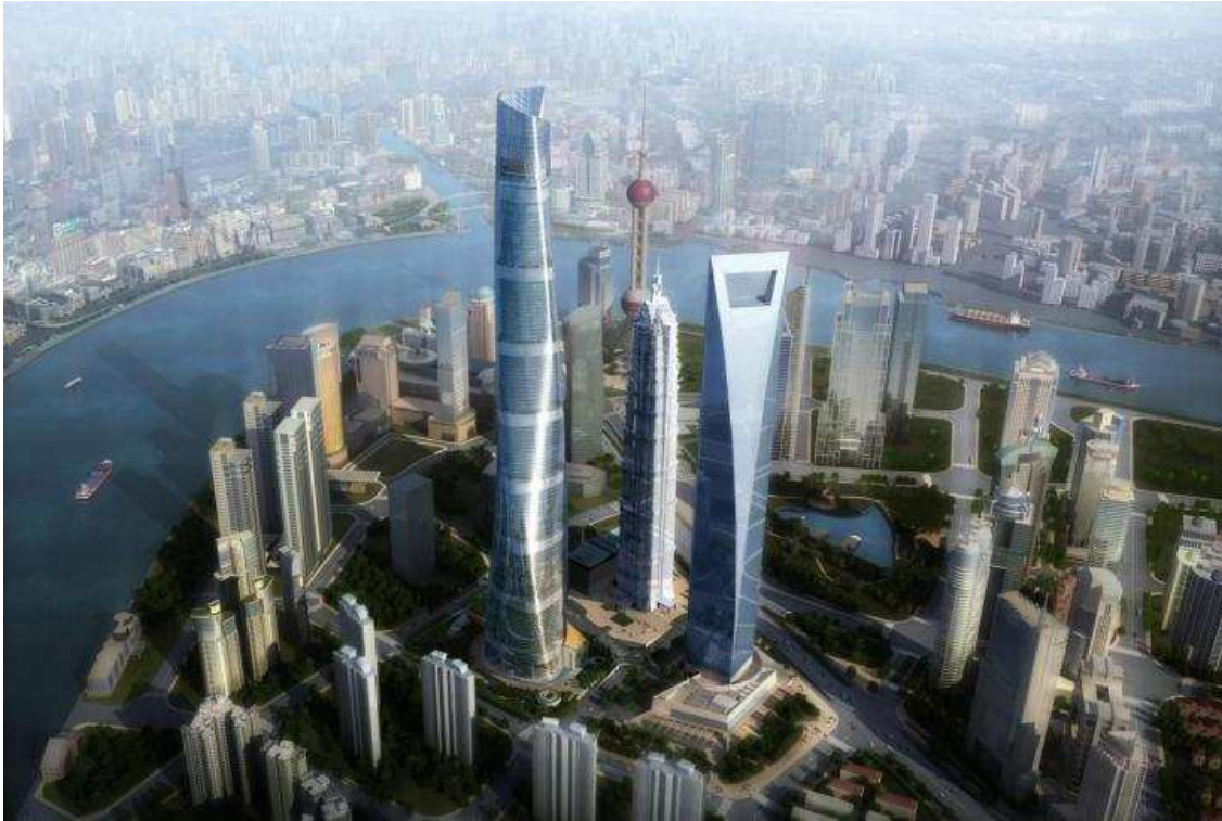
Le quartier de Pudong et la tour de Shanghai, 632m.
